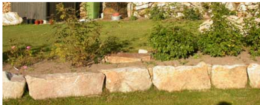
Stora stenar håller jorden i slänten på plats
